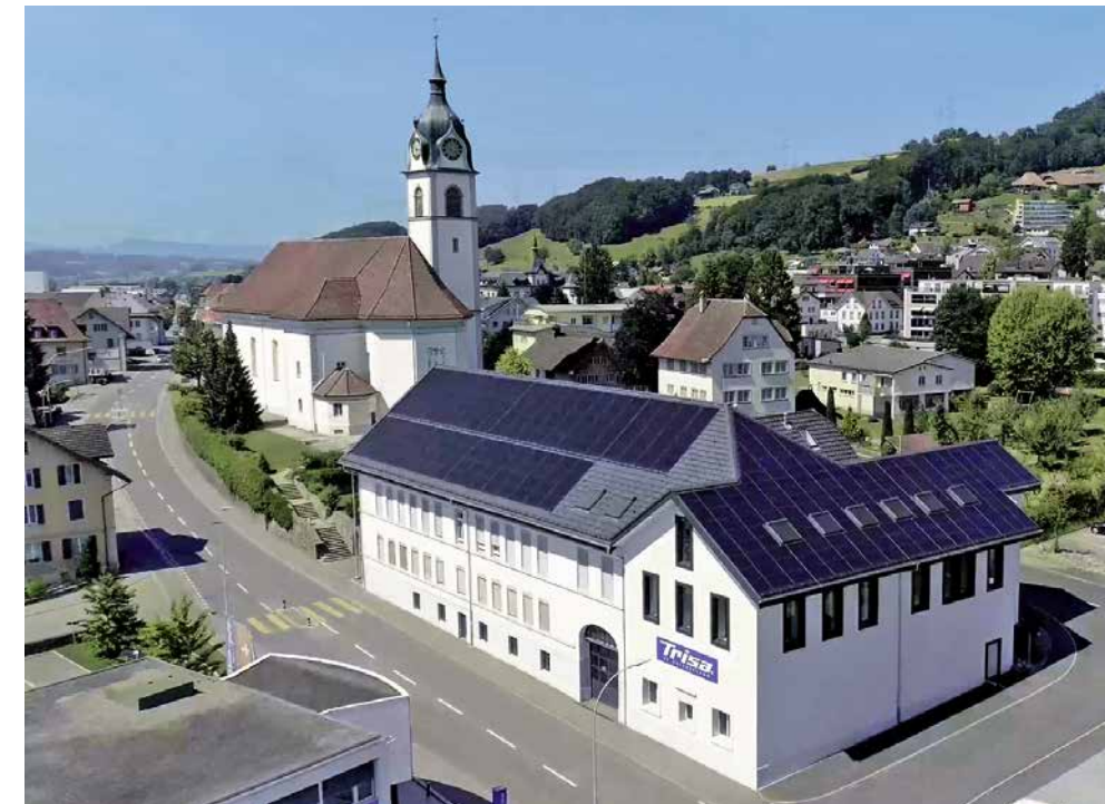
▲ Auf dem Flachdach des «Werk 2» produziert eine moderne Photovoltaikanlage Strom, welcher dem Energiebedarf von über 80 Einfamilienhäusern entspricht.
