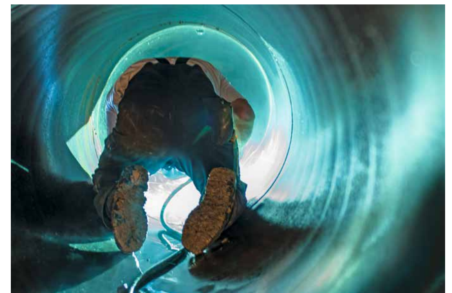
Verlegen von Stahlrohren für den Fernwärmeleitungsbau. ▶
