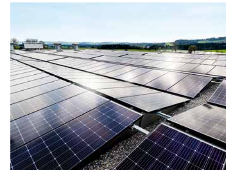
▲ Auf dem Flachdach des «Werk 2» produziert eine moderne Photovoltaikanlage Strom, welcher dem Energiebedarf von über 80 Einfamilienhäusern entspricht.
